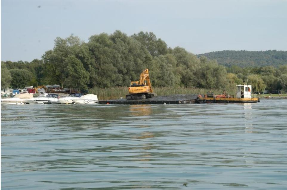
Figura 5.4. Operazione di dragaggio sul Lago Maggiore sotto Angera (VA)
