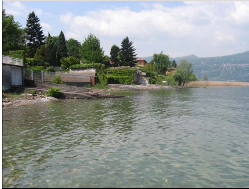
Fig. 5.15 Scivolo di alaggio che interrompe la continuità e la percorribilità pedonale della riva.
