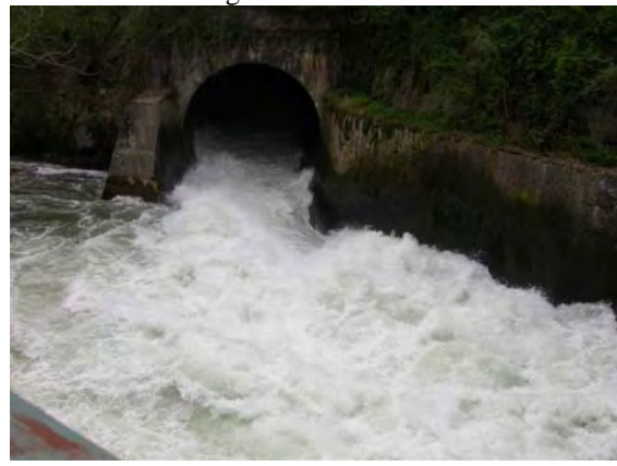
d. Diga di Creva - scarico
